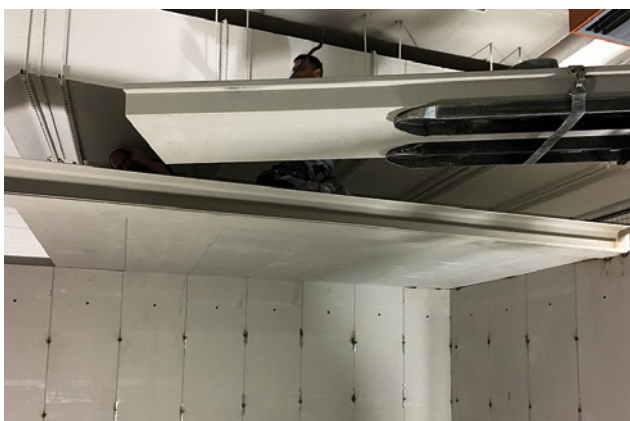
Einbau Deckenelemente
