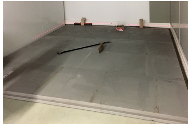
Verlegung des Modulraum-Bodens
